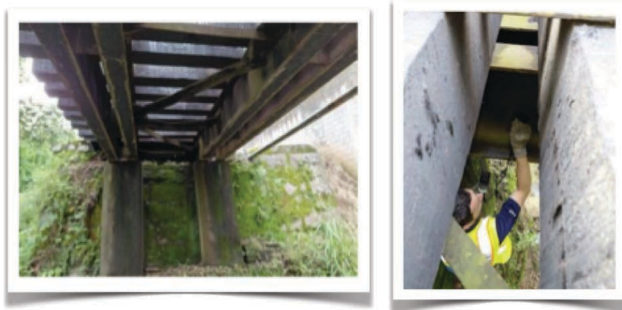
Evaluación de puentes ferroviarios
