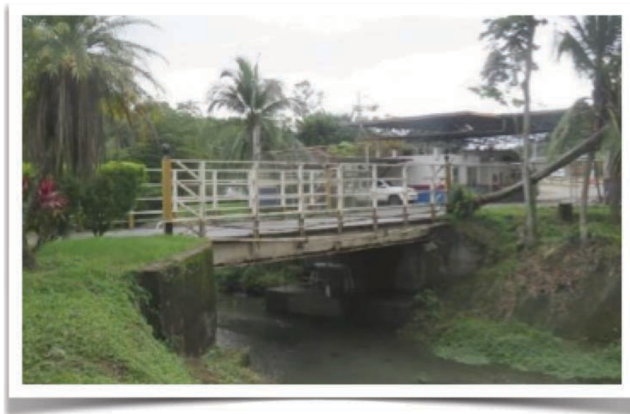
Evaluación de puentes en terminal de RECOPE en Moín.
