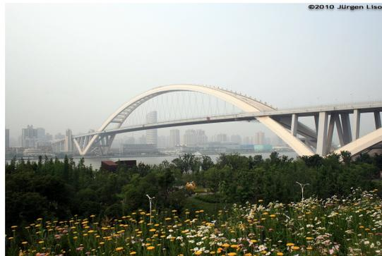
Este puente fue inaugurado el 28 de junio de 2003. Tiene una longitud total de 3,9 km, con el vano central de 550 m. Posee 6 carriles (3 para cada sentido) y su altura máxima contada desde la plataforma es de 90 m. La altura de los pilares laterales donde apoya la plataforma es de 150 m. La estructura del arco es de acero y tiene la forma parabólica.
