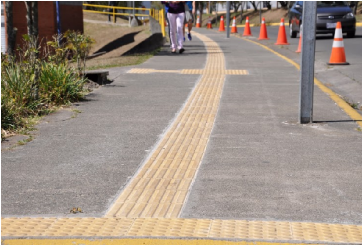
Las baldosas podotáctiles colocadas en las aceras del TEC facilitan la orientación para las personas con discapacidad visual. (Foto: Archivo OCM)
