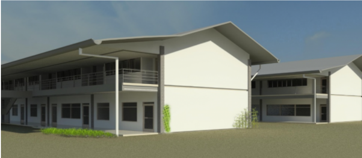
Edificio de aulas y laboratorios en la Sede Regional de San Carlos. (Imagen cortesía: Oficina de Ingeniería)
