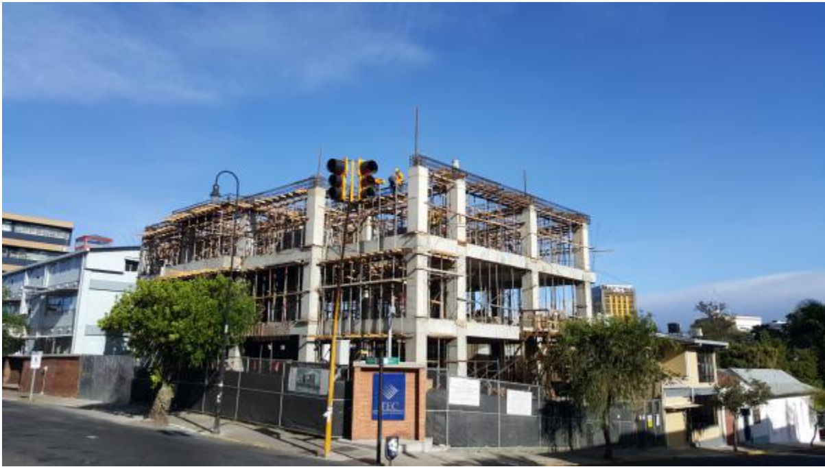
Obras en construcción en el Centro Académico de San José. (Foto cortesía Oficina de Ingeniería)
