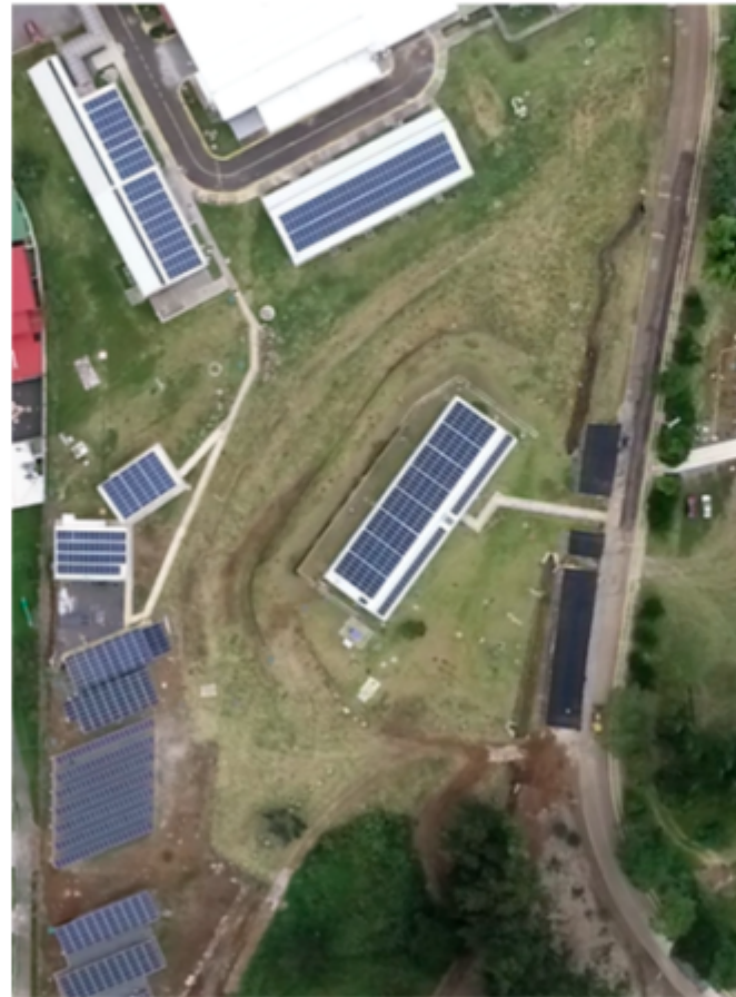
SESLab - Complejo Solar TE
