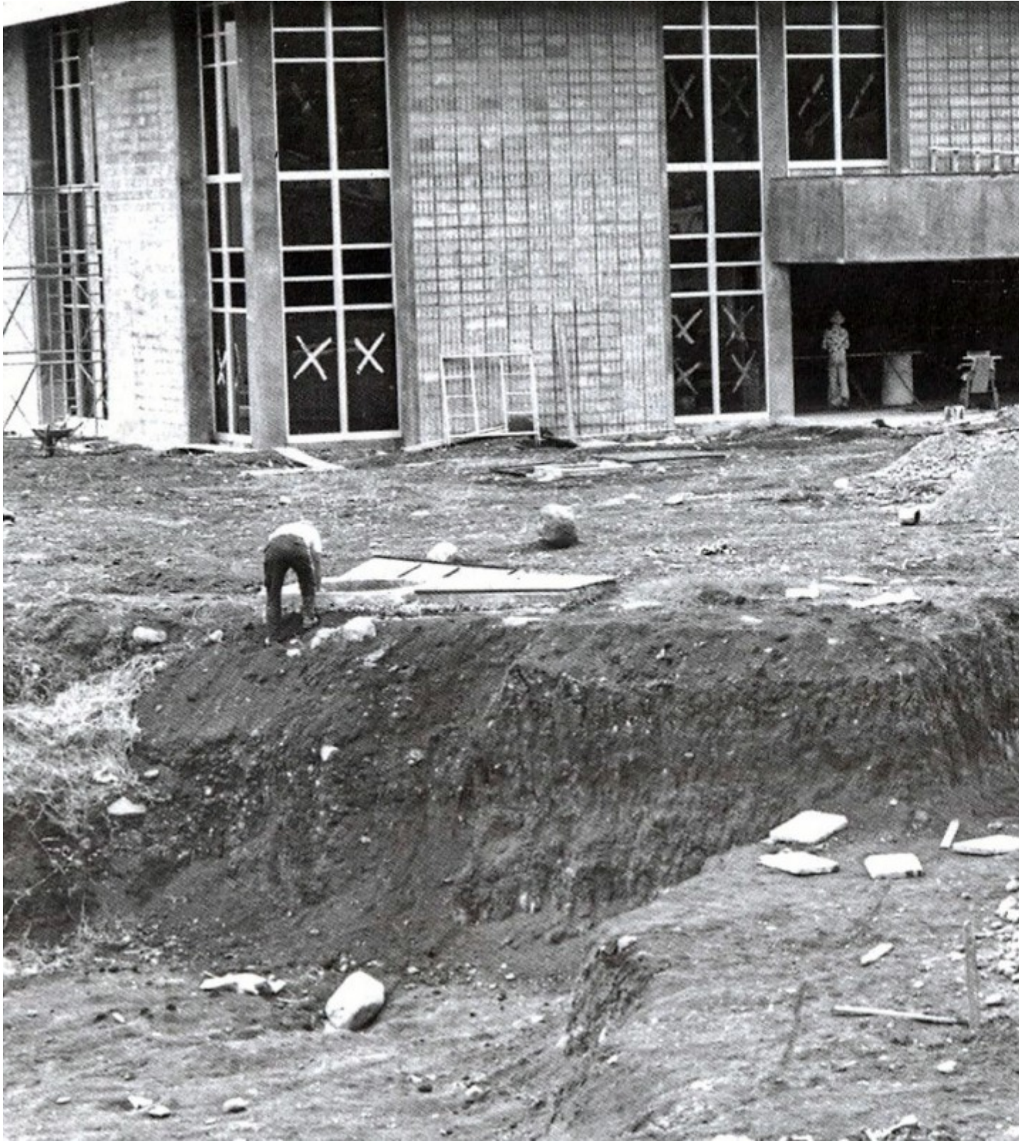
Construcción del actual edificio de la Biblioteca del TEC. Fotografía Archivo TEC.
