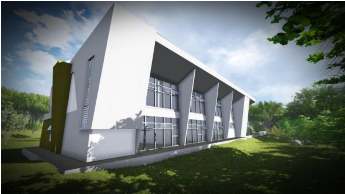
Vista parcial del nuevo edificio. (Oficina de Ingeniería)
