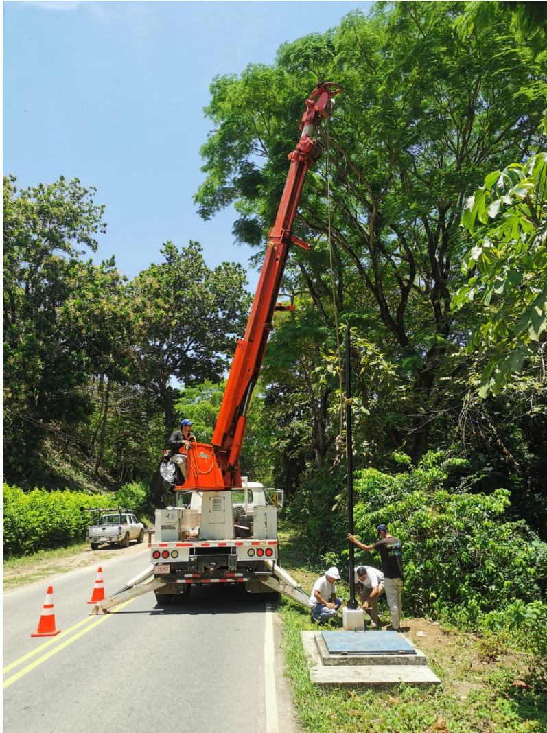
Instalación de uno de los puntos de control. Imagen cortesía de S. Solórzano.
