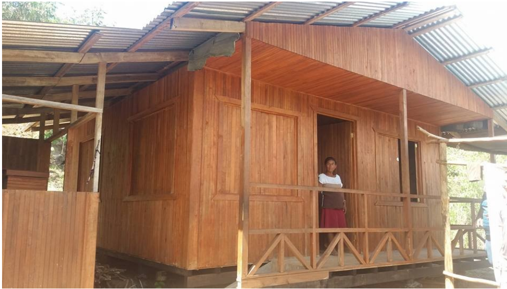
Vivienda de madera, construida con melina, en el territorio indígena Cabagra. Foto: Cortesía D. Camacho.
