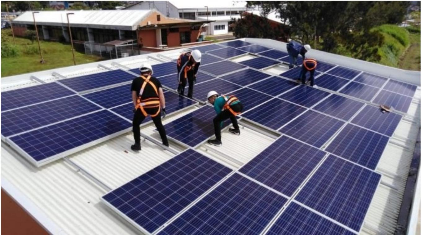
La instalación de los paneles fotovoltaicos sobre el techo de diferentes edificios del TEC fue realizada por estudiantes y profesores de la Institución siguiendo todas las normas de seguridad. **Foto cortesía de Carlos Meza.**
