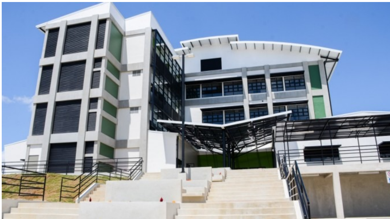
Edificio del Núcleo Integrado de la Escuela de Química [1] - Ambiental [2] fue inaugurado oficialmente. Foto Ruth Garita/OCM.
