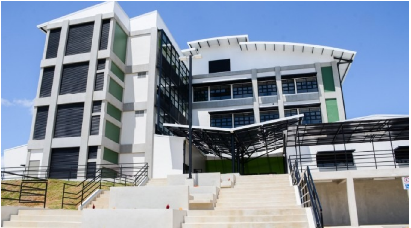
Edificio del Núcleo Integrado de la Escuela de Química [1] - Ambiental [2] fue inaugurado oficialmente. Foto Ruth Garita/OCM.
