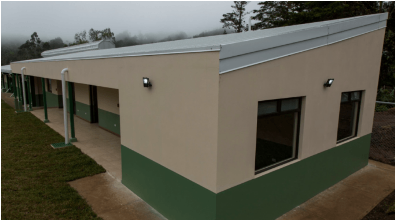
La nueva obra de infraestructura rural se encuentra en el Asentamiento Campesino de La Estrella del Guarco, ubicado en San Isidro de El Guarco, Cartago. (Foto cortesía de Casa Presidencia).
