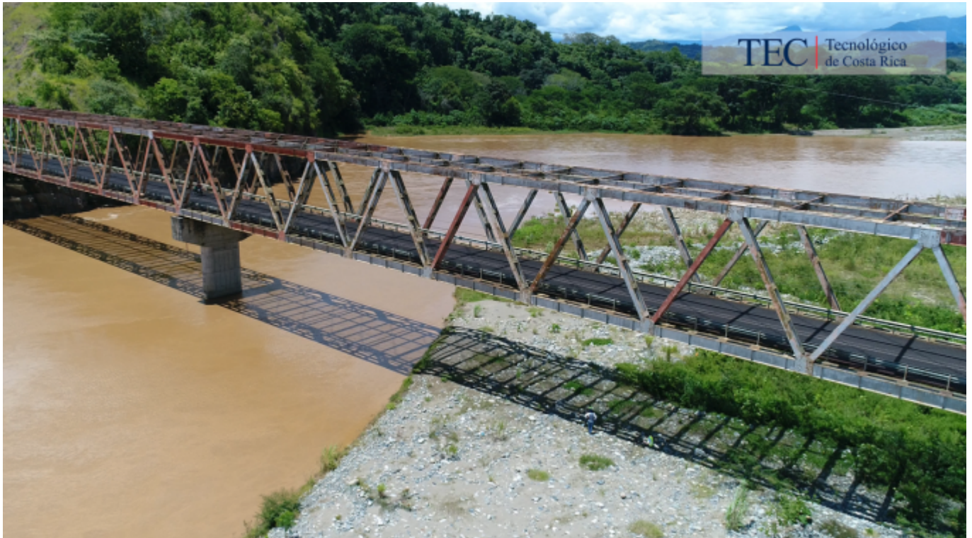
Fotografía con fines ilustrativos, cortesía eBridge.
