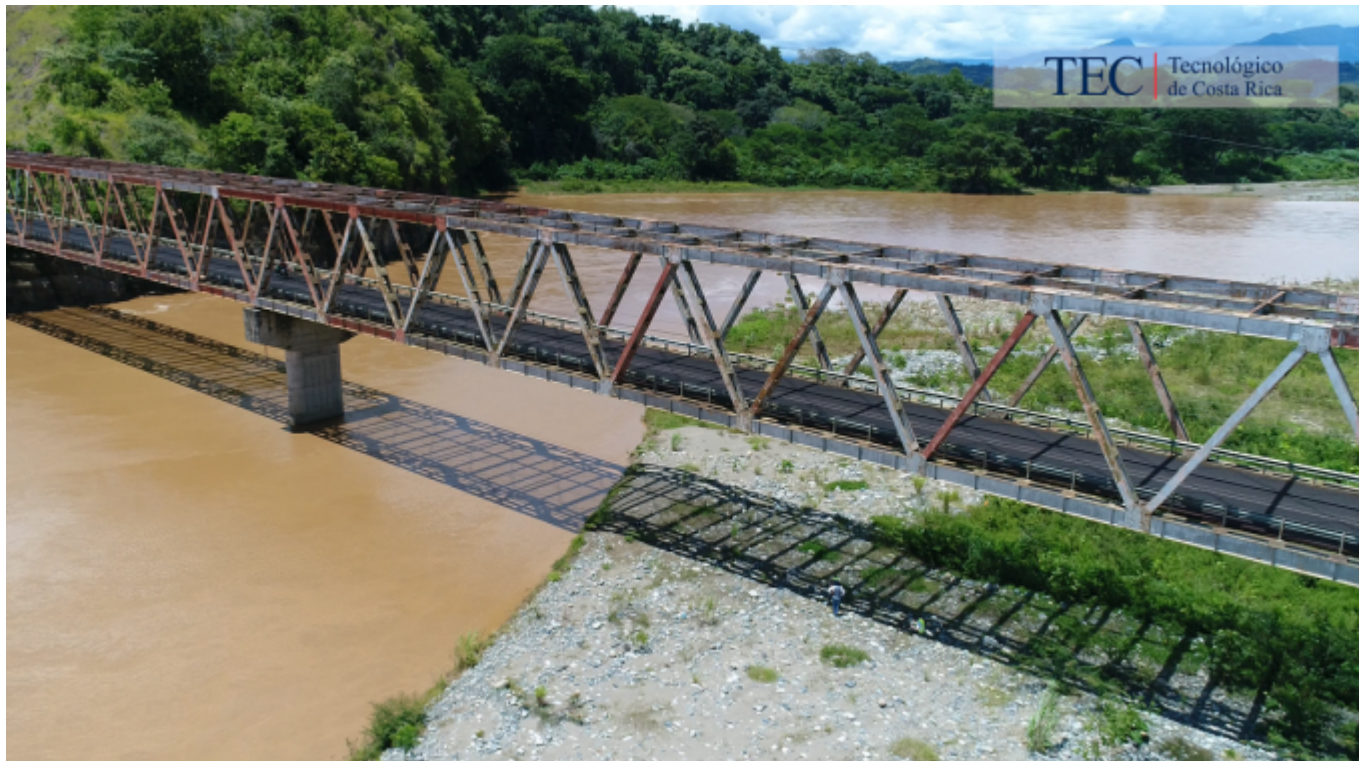
Fotografía con fines ilustrativos, cortesía eBridge.
