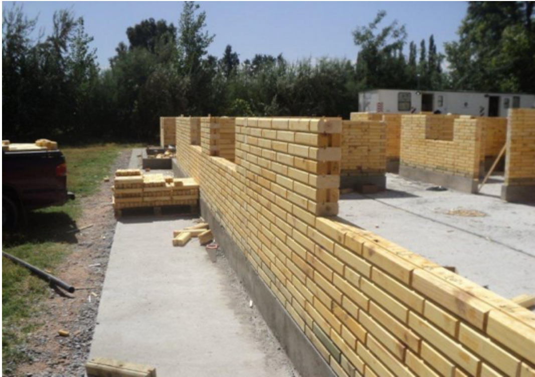
Sistema constructivo BME, Argentina. (Fotografía: Julio Nespeca-EIFO).
