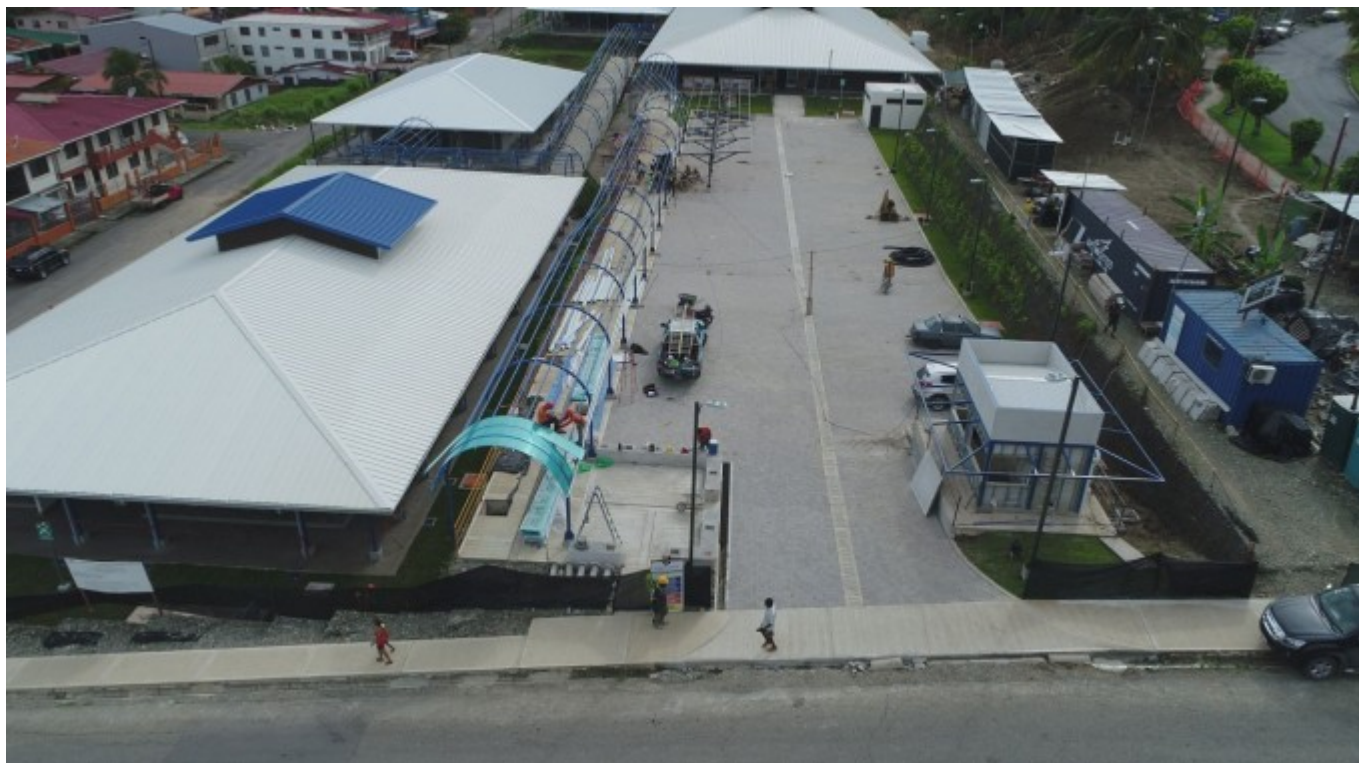
Instalaciones del nuevo Centro Académico de Limón. Foto cortesía de Jessica Salazar.
