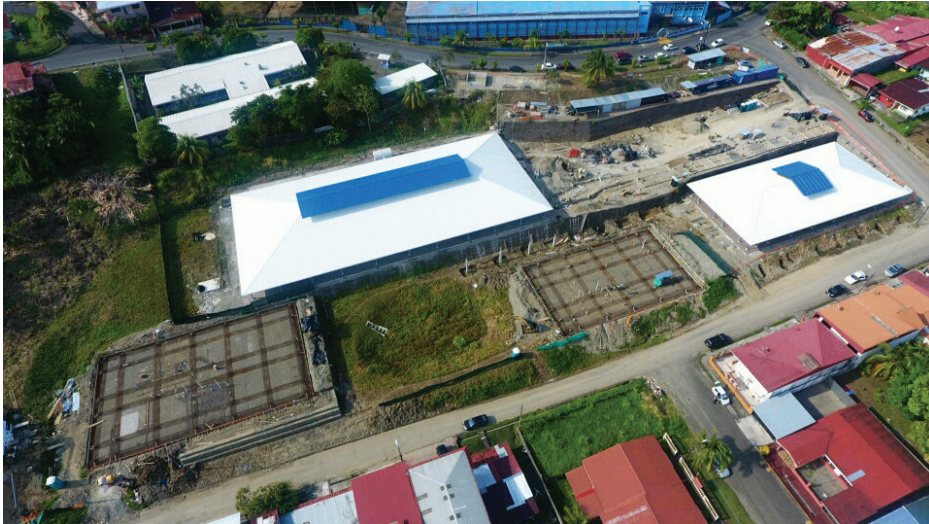
Nuevas instalaciones del Centro Académico de Limón
