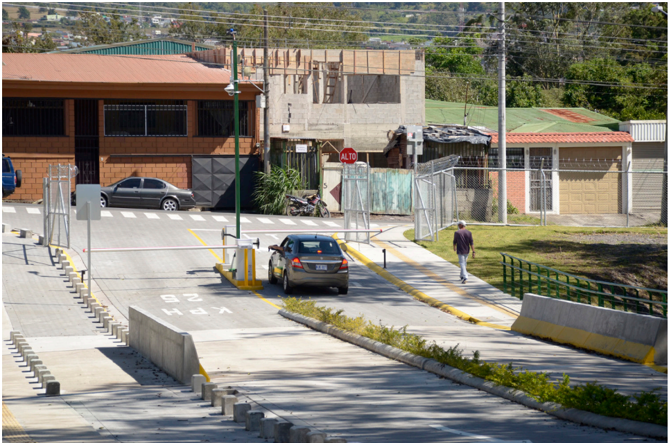
Puente acceso norte del Campus.
