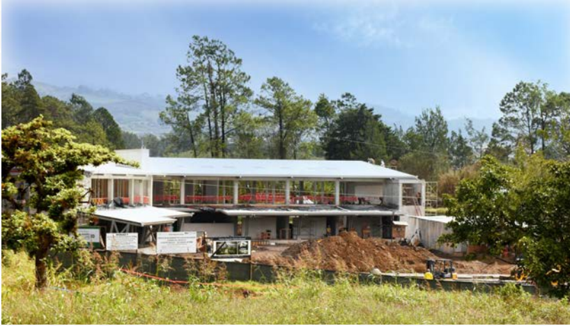
Construcción del edificio de la Escuela de Ingeniería en Diseño Industrial
