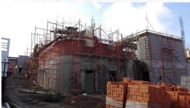
Construcción del edificio de Ingeniería en Seguridad Laboral
