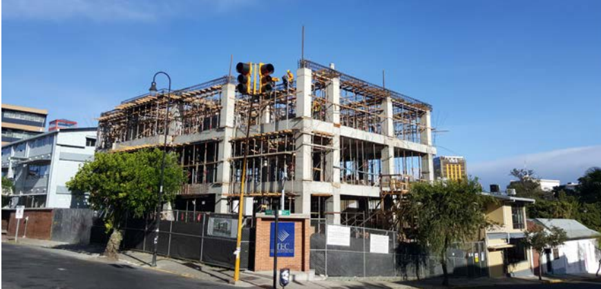
Construcción de nuevas obras en el Centro Académico de San José.
