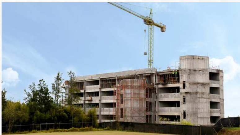
Construcción de edificio de Escuela Ingeniería Electrónica
